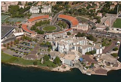
Hôtel de ville de Martigues (vue aérienne)
