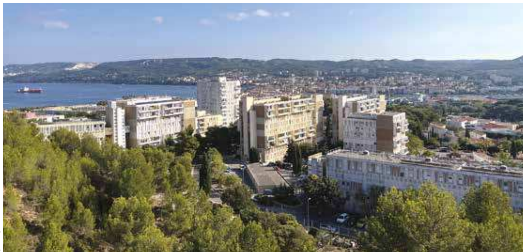
D'ici le mois de mars le bâtiment K-M aura été détruit par voie de grignotage. Les bâtiments voisins sont tous expertisés.
