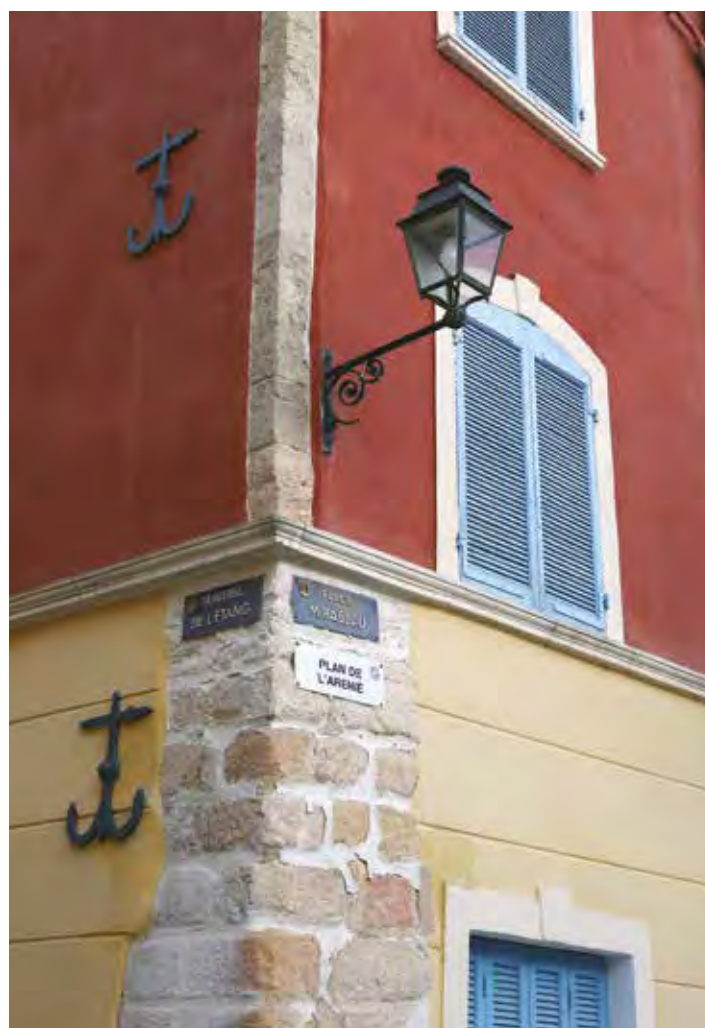
La couleur des façades est soumise à la validation de l'architecte des bâtiments de France.
