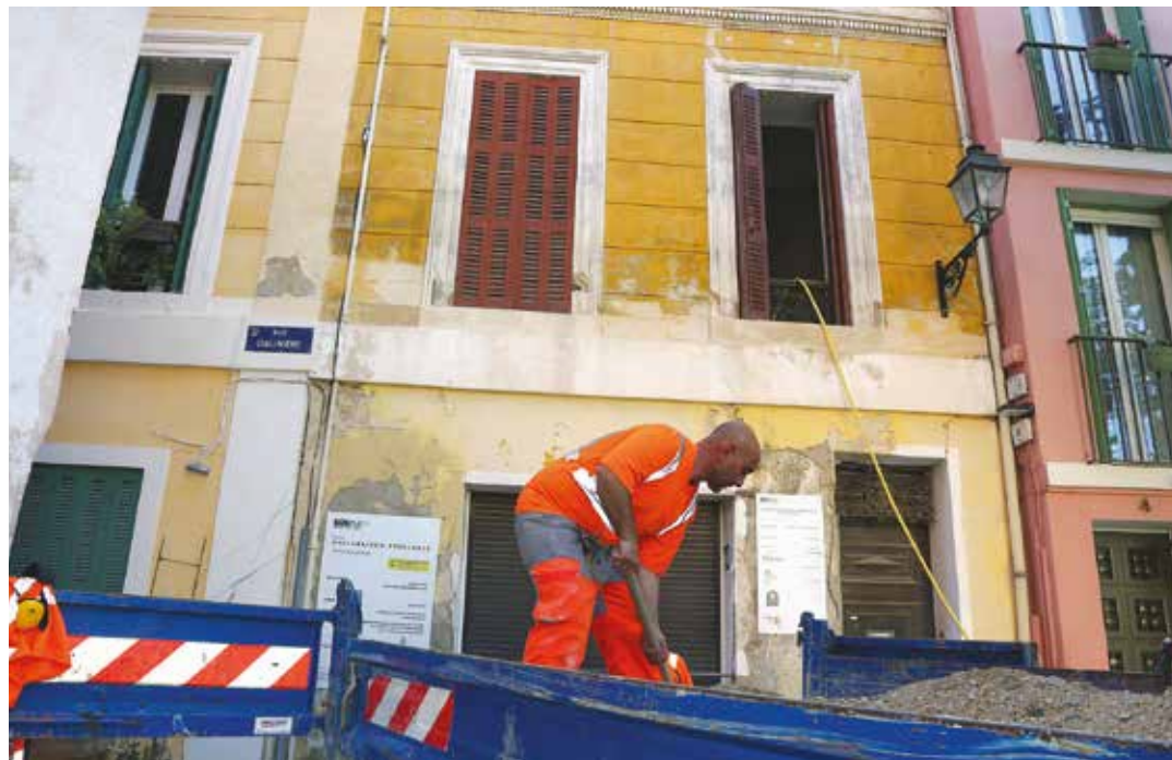
Actuellement en travaux, l'immeuble de la place Mirabeau sera l'objet d'un projet innovant pour rompre l'isolement des seniors.
