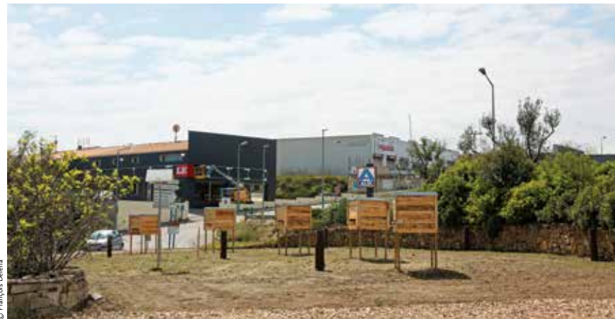
Sur le rond-point de Croix-Sainte, un exemple du nouvel aménagement des espaces verts.
