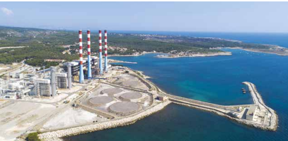
Depuis son passage du fioul au gaz, le site d'EDF Ponteau vit une véritable transformation. Finis les bacs de stockages et bientôt, les cheminées.
