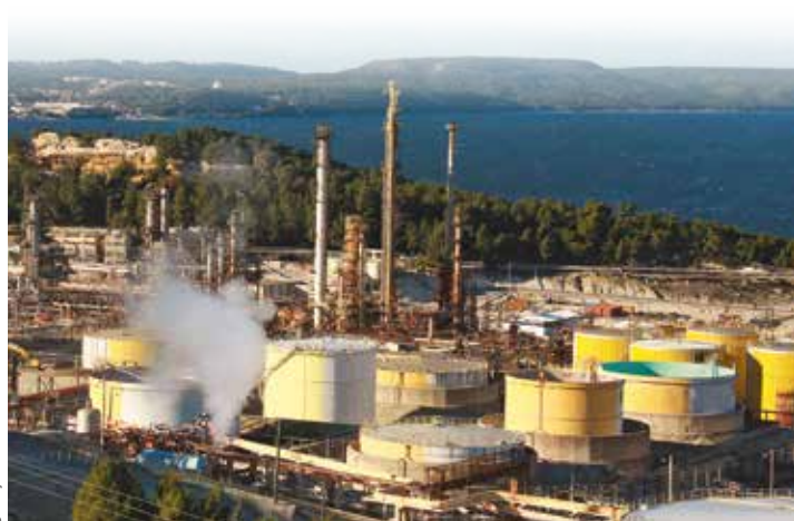
Vingt mille tonnes d'huile de palme sont arrivées par bateau et sont stockées sur le site.
