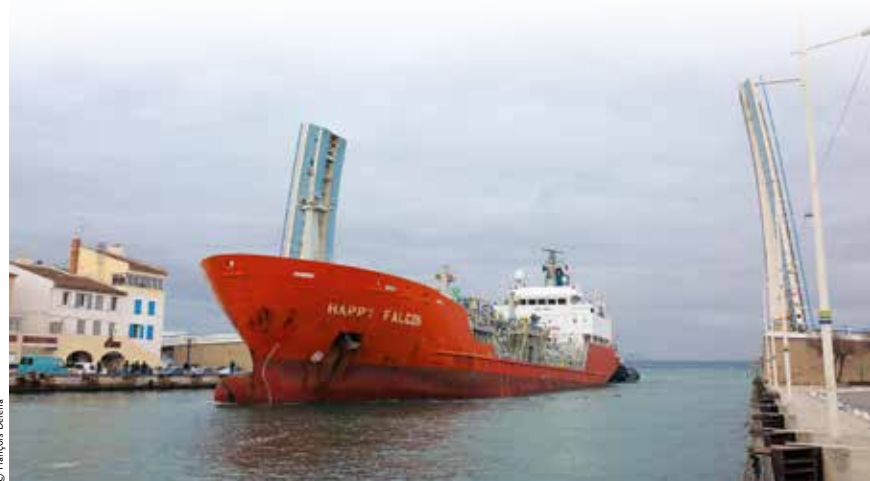
Le pont levant se situe sur le seul canal d'entrée dans l'étang pour les navires importants.
