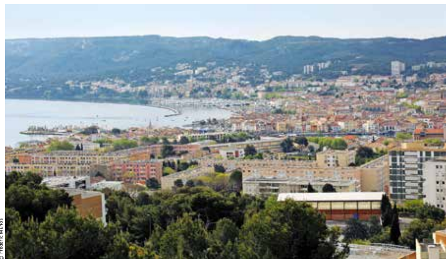
Le respect des règles d'urbanisme est l'un des chantiers de ce nouveau service municipal.
