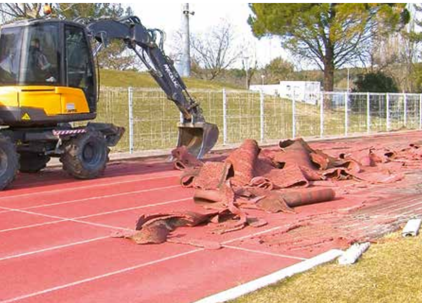
Le revêtement et la structure de la piste sont en train d'être rénovés.
