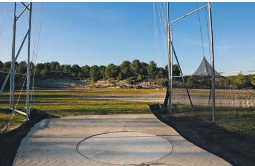
La cage de marteau sur le plateau de lancers fait partie des travaux engagés.
