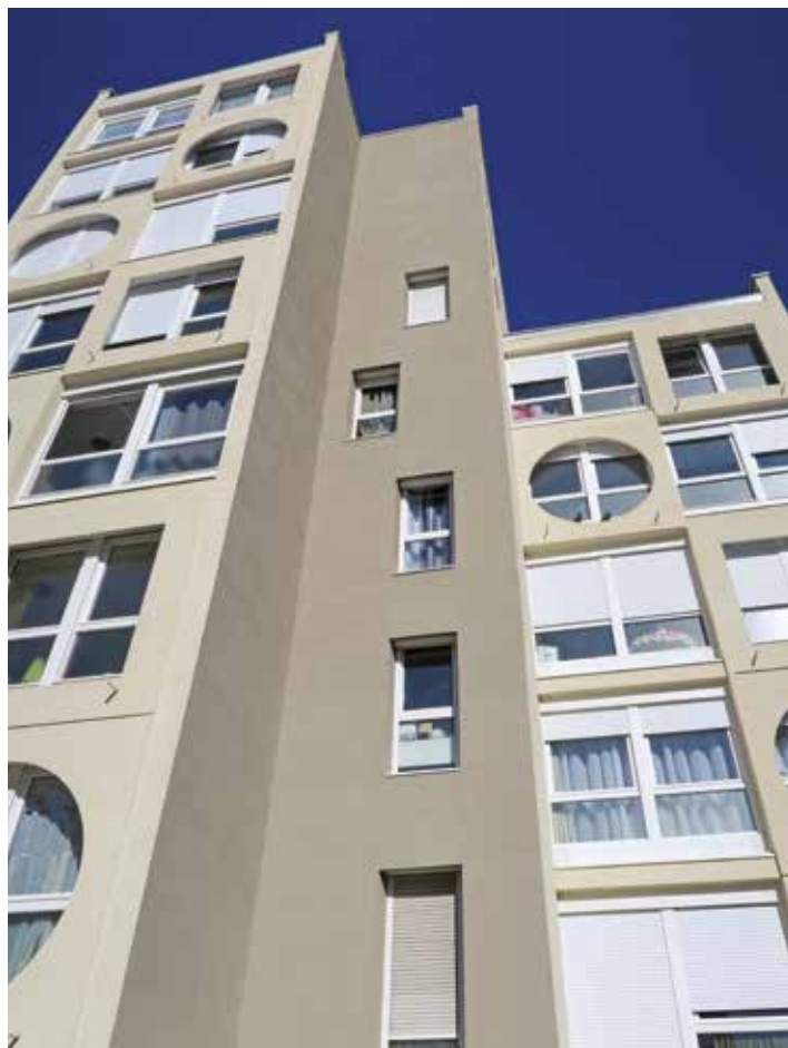
367 logements ont subi des travaux de rénovation qui ont duré 18 mois.
