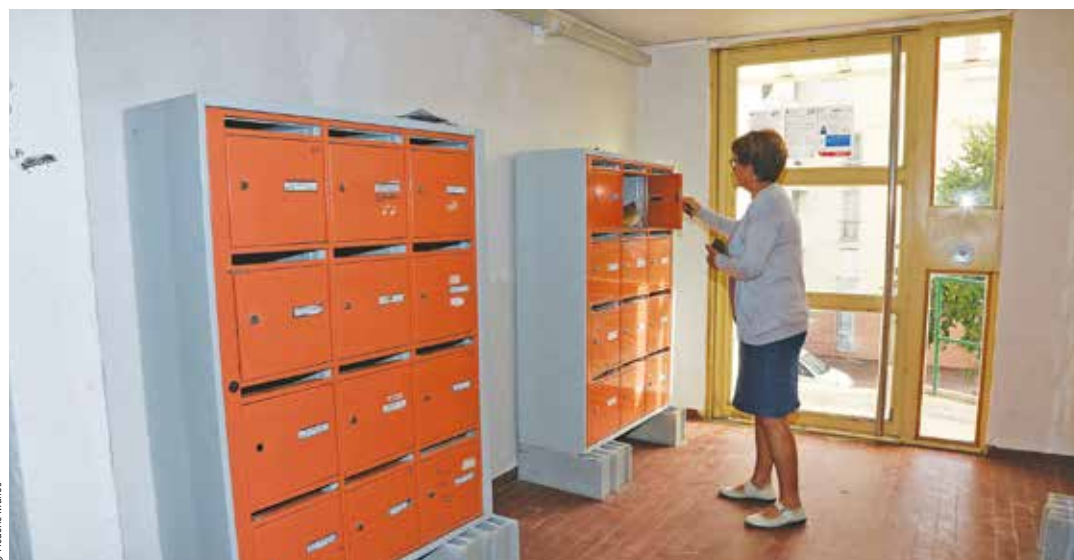
Les halls d'entrée sont loin d'être terminés, plus d'interphone, plus de lumière et des boîtes à lettres posées au sol.
