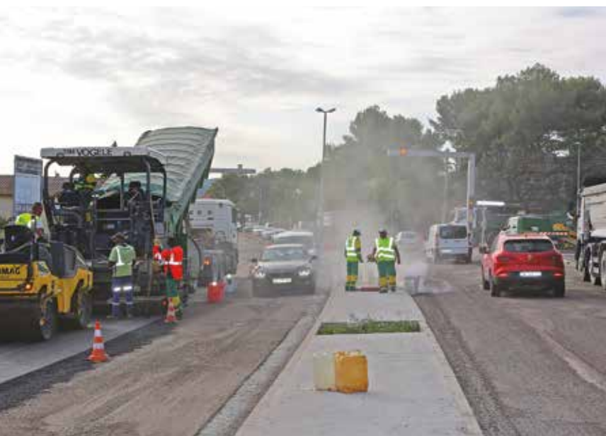
Après plusieurs mois d'intense chantier, les travaux de l'entrée nord touchent à leur fin.
