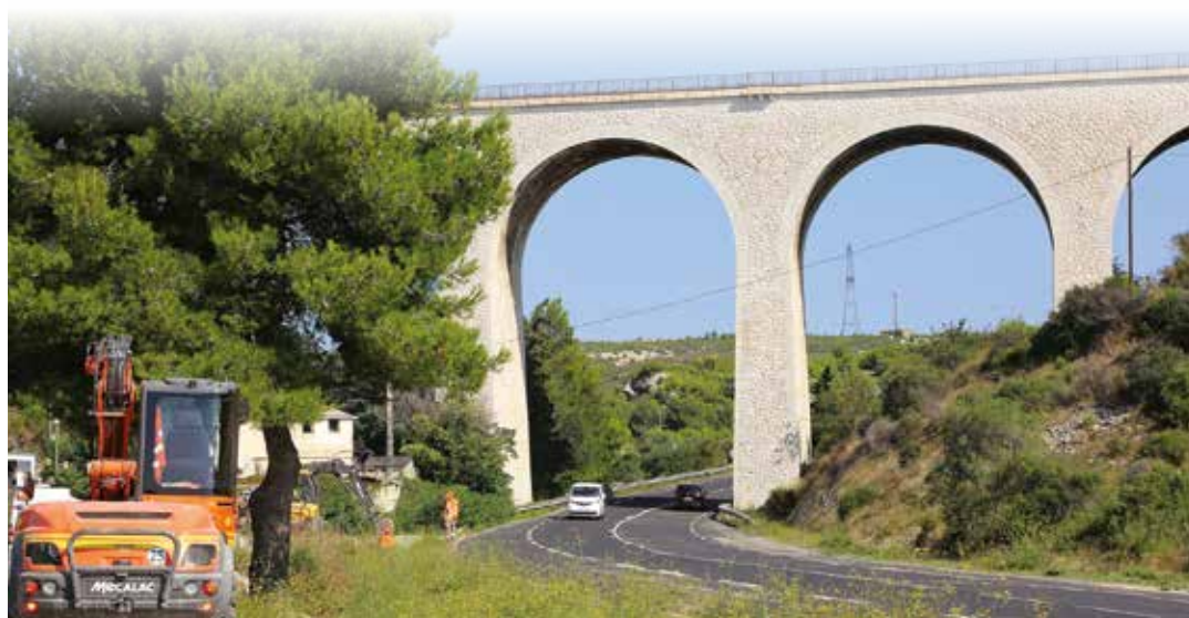
Les travaux ont démarré par la contre-allée. Un giratoire sera créé à proximité du viaduc ferroviaire pour fluidifier la circulation.
