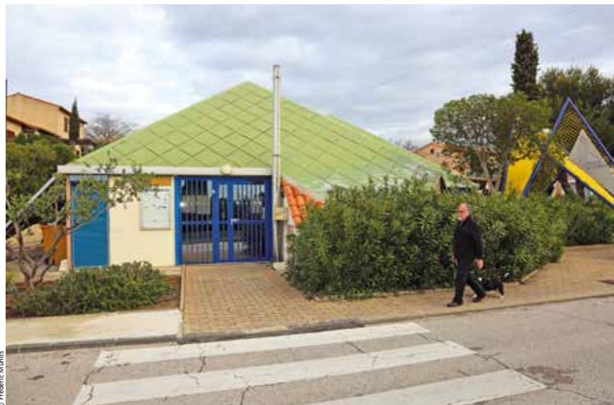
La Maison de quartier de Lavéra va connaître des travaux d'ampleur d'ici la fin du mois.
