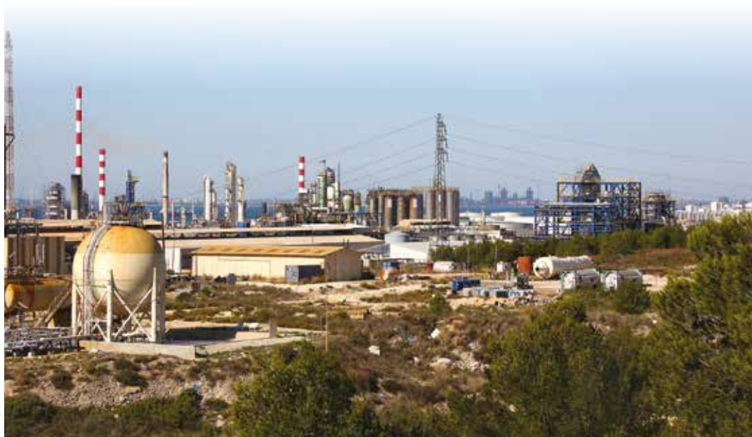
Après la construction de la salle membrane, il faudra plusieurs années pour démanteler les unités obsolètes.
