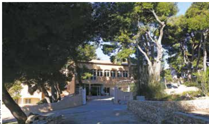
Le bâtiment a bénéficié d'une rénovation à haute performance énergétique.
