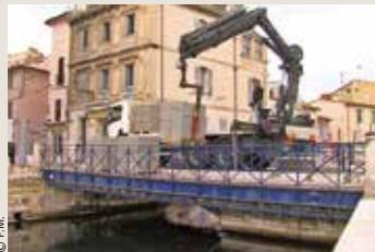
C'est la question à laquelle les services techniques de la Ville ont tenté de répondre. Après repérage de points de corrosion sur le pont ouvert à la circulation automobile, des tests de solidité ont été réalisés, le mois dernier. Comment ? En plaçant sur le pont un camion chargé de blocs en béton, dont le poids total
