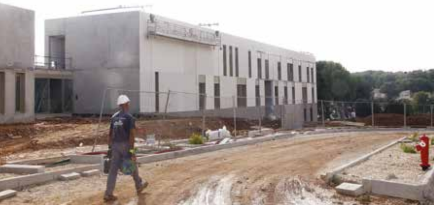
Au mois de février, le chantier du nouvel EHPAD Les Oliviers devrait être achevé.
