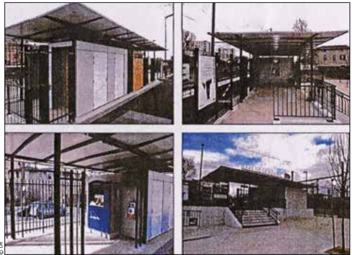
La future gare de La Couronne ressemblera à celle du quartier de La Pomme à Marseille.
