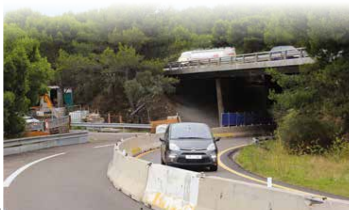
Durant la période des travaux, jusqu'à la fin janvier, la vitesse sera réduite à 50 km/h.
