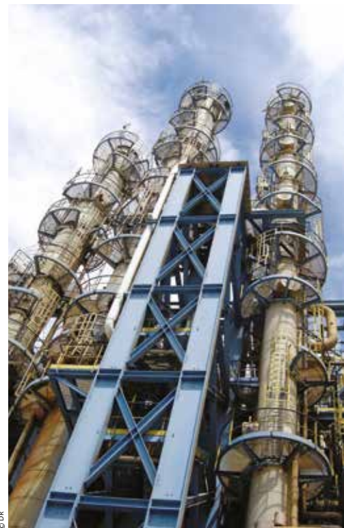
L'usine est en pleine modernisation.
