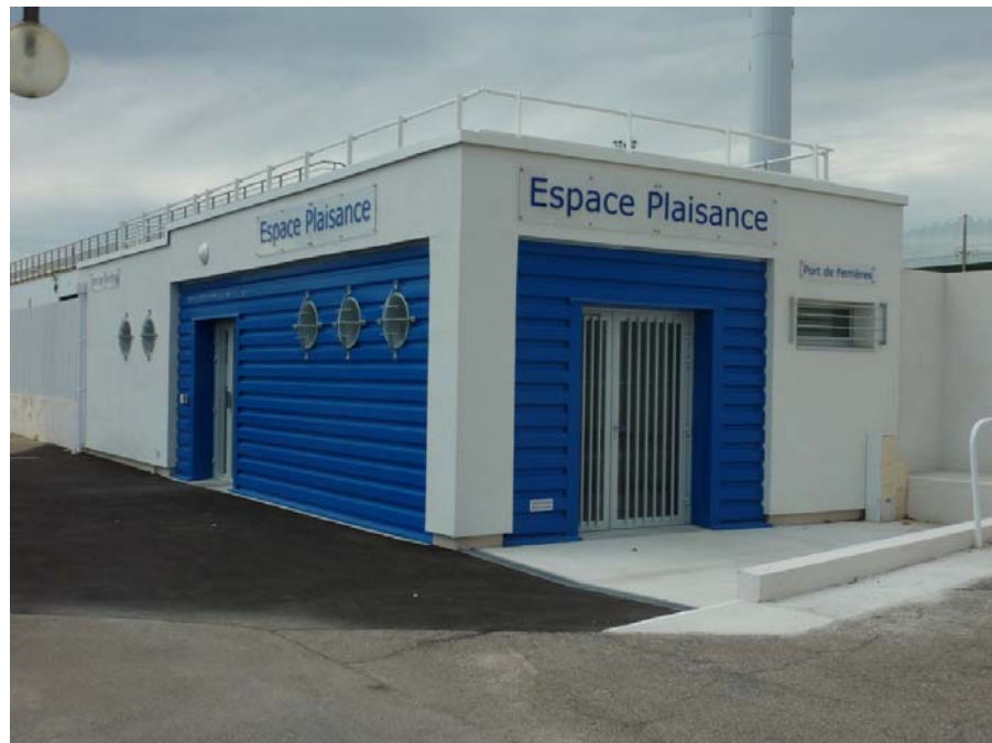
Espace d'accueil des plaisanciers – Port de Ferrières
