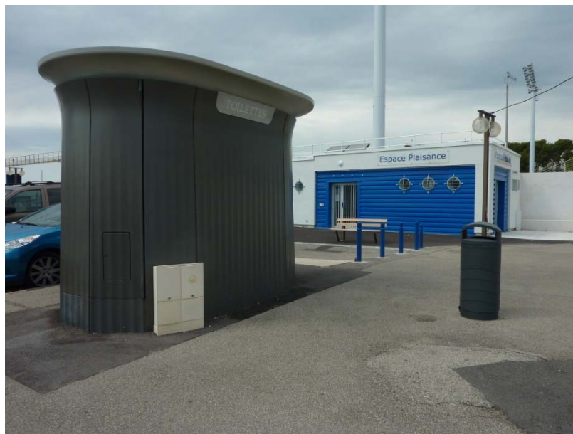
Sanitaires publics et Espace Plaisance – Port de Ferrières
